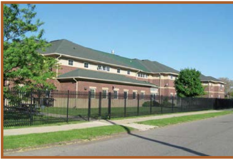
Complesso di "Freedom house".
